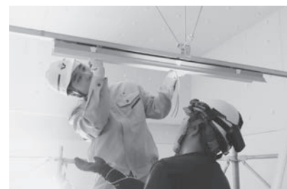
照明器具の取り付け作業を体験しました
