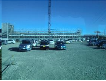
【災害公営住宅錦団地建設工事現場】
