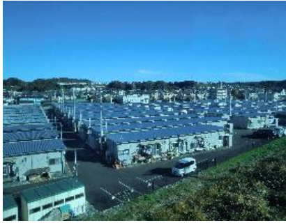
【いわき市泉の応急仮設住宅】
