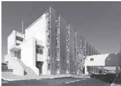
本館棟外観(配管等をアルミルーバーで保護)
